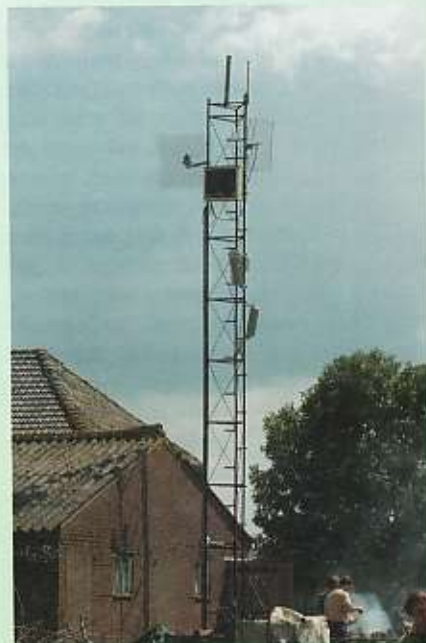
De antennemast met twee Point-to-Point en 3 sector antennes.
